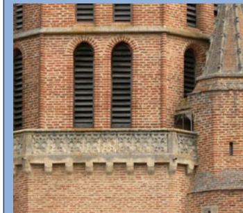
La maçonnerie en brique et les éléments sculptés en pierre.
