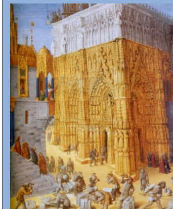
Chantier du Temple de Jérusalem, enluminure du 15 e siècle.
