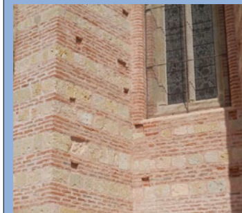
Les trous de boulins sur l'abside.
