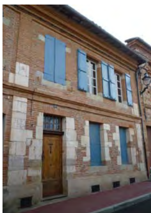
Pierre de taille réservée aux encadrements et modénatures (Grande rue Jouxagues et rue Peyras).
