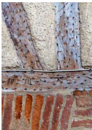
Marques d'assemblages entre une solive et des poteaux (III et IIII), et assemblage à mi-bois d'une croix de Saint-André.
