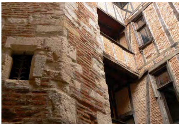
Cour intérieure de la « maison du Vieux Lavour » : tour d'escalier à vis, coursières en pan de bois et fenêtres à traverses.
