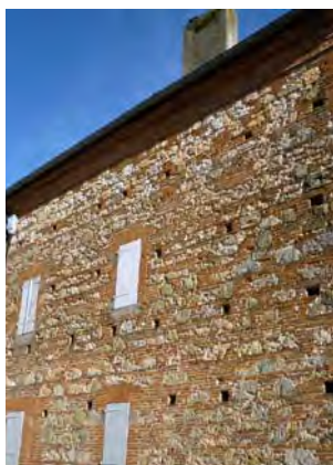
Maçonneries mixtes à assises alternées de briques et moellons de calcaire gréseux.
