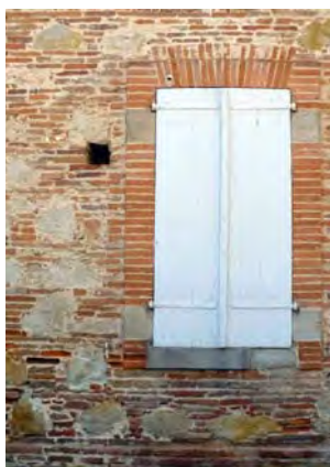
Encadrements saillants en brique apparente et maçonnerie destinée à être enduite.
