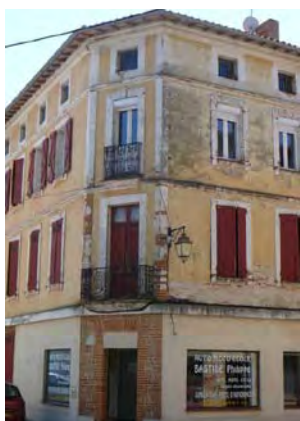
Angles de façades du XIX e siècle : pan coupé de la largeur d'une travée, ou chanfrein terminé par une trompe.
