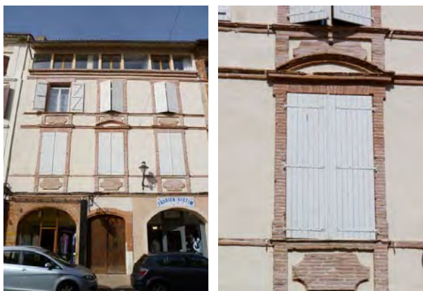
Immeuble du 14 Grand rue, détail du décor de la fenêtre centrale.
