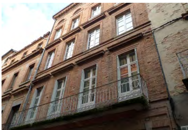
Façade d'immeuble construit en deux temps, XIX e siècle (40 rue Père Colin).
