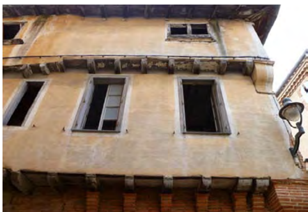
Façade de la maison à double encorbellement du 13 rue Père Colin.
