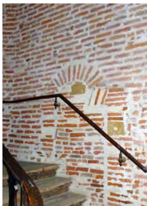
Anciennes niches ou placards en plein cintre dans des maçonneries en brique, aux environs des Cordeliers.
