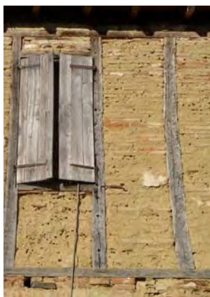
Maçonnerie alternant brique cuite et crue, et hourdis de pan de bois en brique crue.
