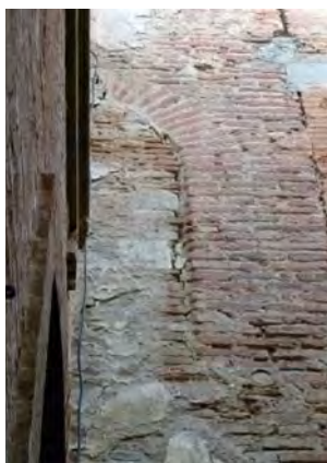
L'ancienne tour des Cordeliers (impasse du Rat) : baie à arc brisé et façade arrière (maçonneries médiévales).
