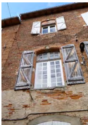
L'ancienne tour des Cordeliers (impasse du Rat) : baie à arc brisé et façade arrière (maçonneries médiévales).
