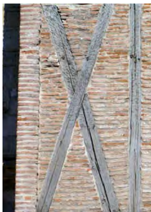
Marques d'assemblages entre une solive et des poteaux (III et IIII), et assemblage à mi-bois d'une croix de Saint-André.
