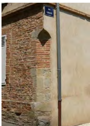
Angles de façades du XIX e siècle : pan coupé de la largeur d'une travée, ou chanfrein terminé par une trompe.
