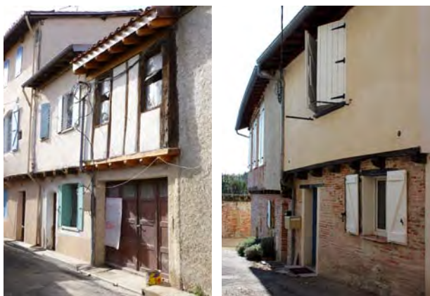
Types de maisons élémentaires à un étage en pan de bois (rues Vergadaud et du Pas).
