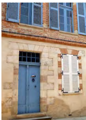
Pierre de taille réservée aux encadrements et modénatures (Grande rue Jouxagues et rue Peyras).
