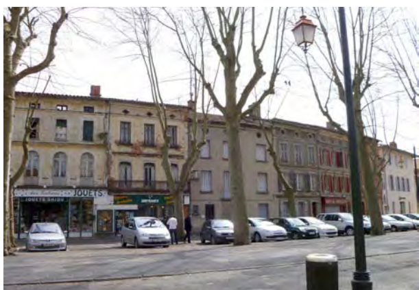
Alignement de façades du XIX e siècle sur les allées Jean Jaurès.
