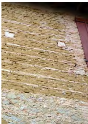
Maçonnerie alternant brique cuite et crue, et hourdis de pan de bois en brique crue.
