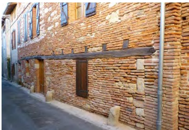
Maison dont les étages en pan de bois ont été reconstruits en maçonnerie. La sablière d'origine est encore conservée (rue du Reilhon).
