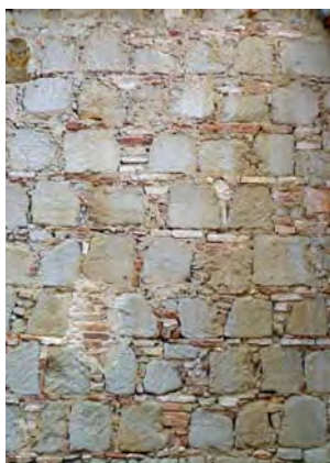
Maçonneries mixtes à assises alternées de briques et moellons de calcaire gréseux.
