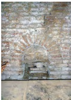
Anciennes niches ou placards en plein cintre dans des maçonneries en brique, aux environs des Cordeliers.
