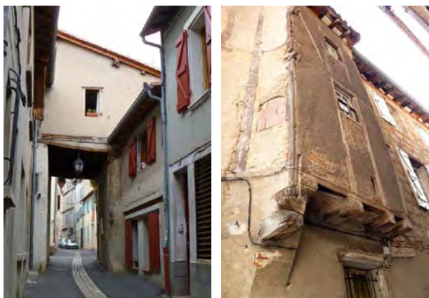
Le « pontet » de la rue Valat-Viel, et vestiges d'un ancien passage surélevé rue Château-Renard.
