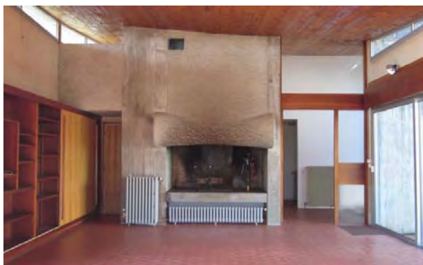
Dans le salon, Debeaux a réalisé lui-même la cheminée sculpturale en acier recouvert de béton.
