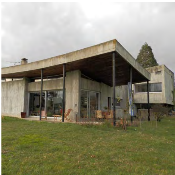
Le auvent qui protège la terrasse au sud-est.
