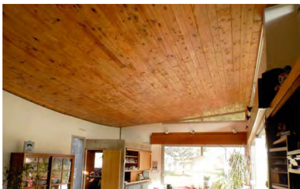
Dans le salon, le coffrage de la toiture en lames de bois est laissé apparent.
