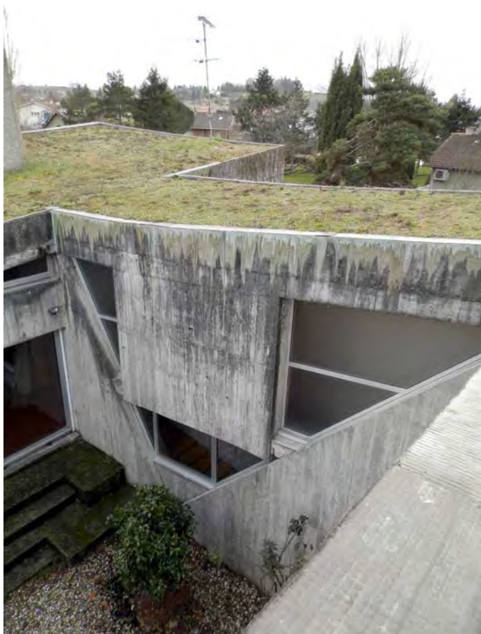
Vue depuis le toit, vers l'ouest.
