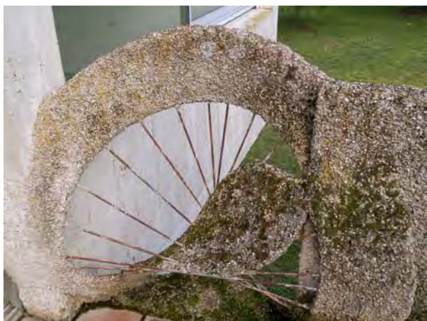
Garde-corps de la petite terrasse en forme de volute.
