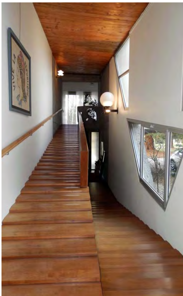
Les rampes intérieures, vues depuis le sud.
