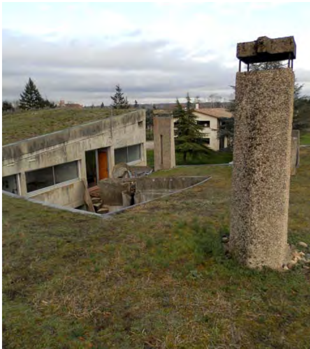
Vue depuis le toit, vers le nord-est.
