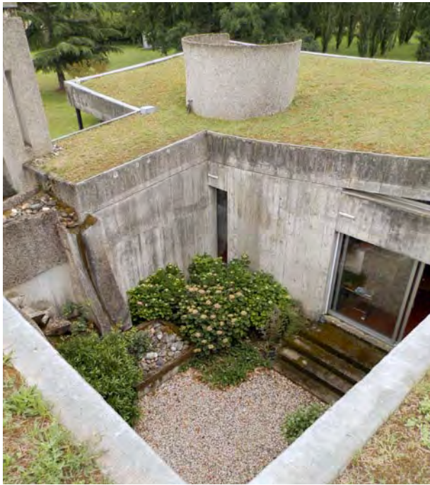
Le toit est une surface réglée, qui s'élève en tournant. Vue depuis le toit, vers le sud-est.
