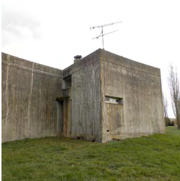
Mur occidental quasiment aveugle, construit sans reprise de coulage à près de 6 m de hauteur.
