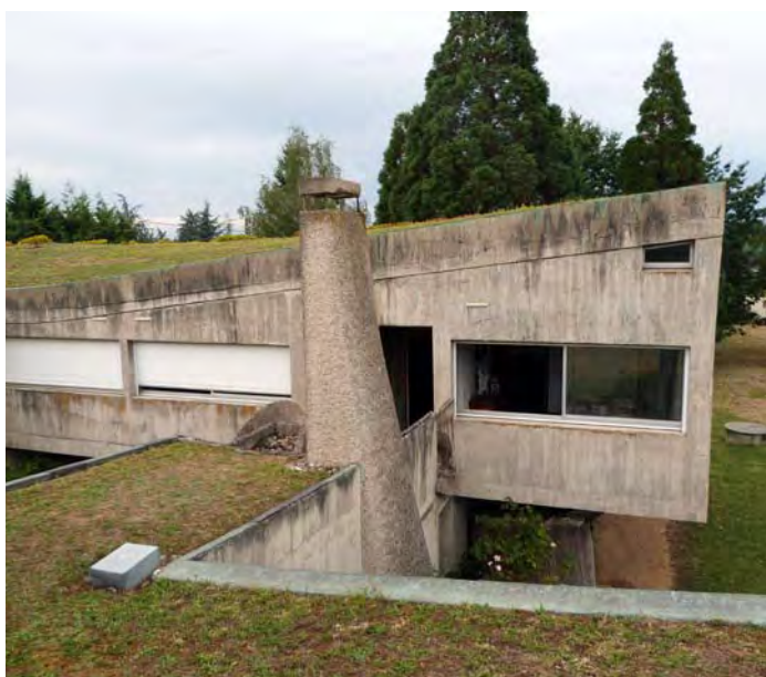
Vue depuis le toit vers la chambre principale.
