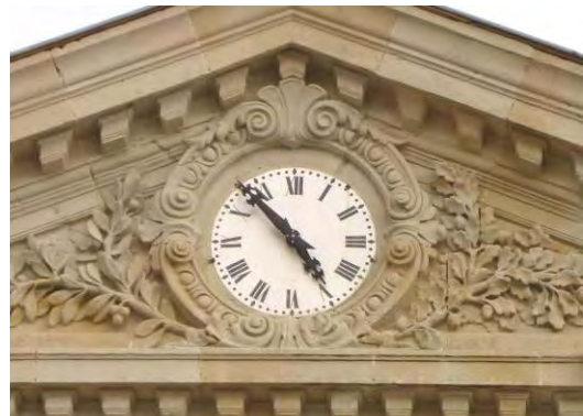
Encadrement de l'horloge : frise d'oves, de perles et de feuillages. Corniches à modillons.
