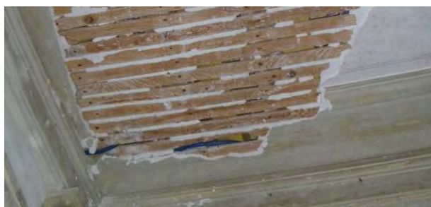
Plafond en plâtre sur lattes de sapin.
