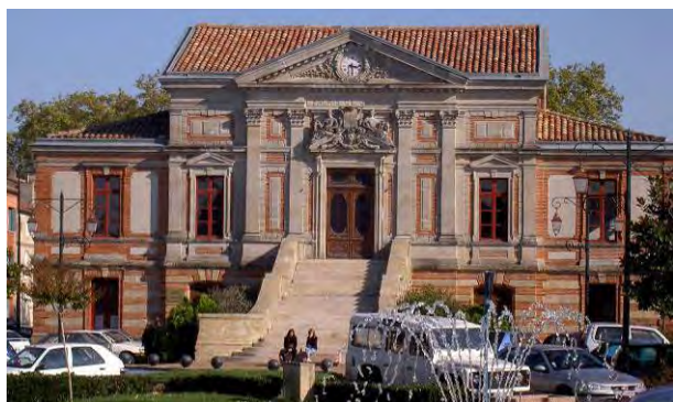
La façade avant travaux.
