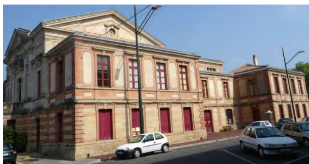
Façade latérale sud.
