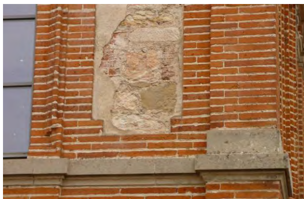
Maçonnerie de brique, encadrement de fenêtre en brique taillée, modénature en pierre de taille, et trumeaux en maçonnerie de moellons et briques, destinée à être enduite.
