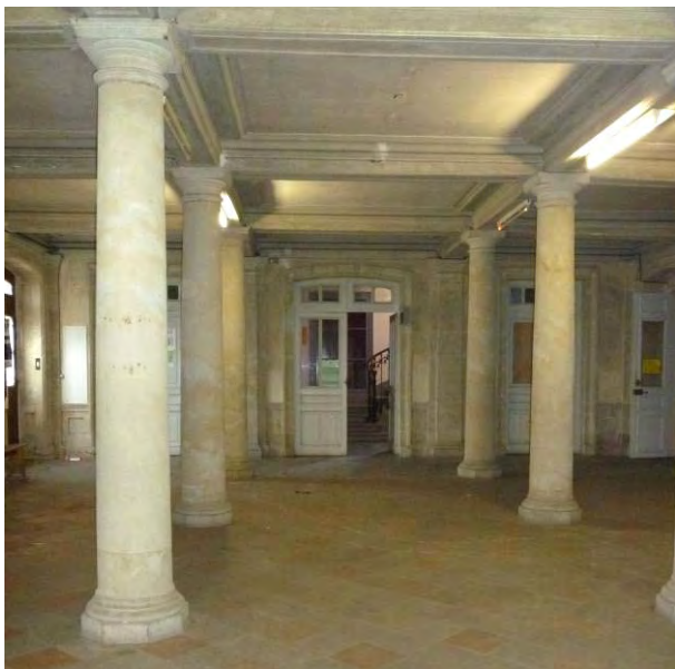
Vestibule avant travaux.
