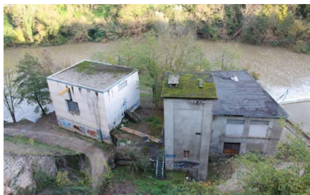
L'usine hydro-électrique en 2013.
