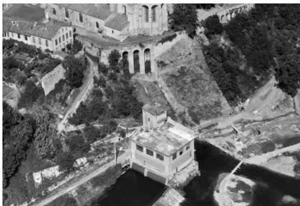
L'usine hydro-électrique, photographie aérienne de 1953, Roger Henrard (AD81, 8 Fi 140).
