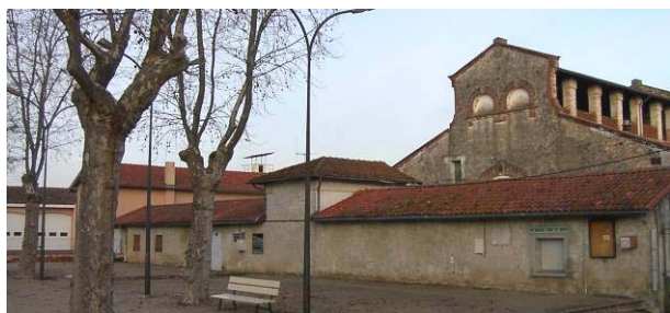
Vue générale depuis l'ouest avant réhabilitation (2009).
