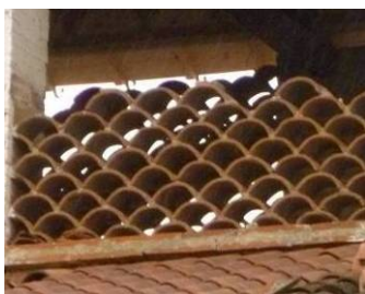
Détail des claustras en tuiles canal de l'étage supérieur.
