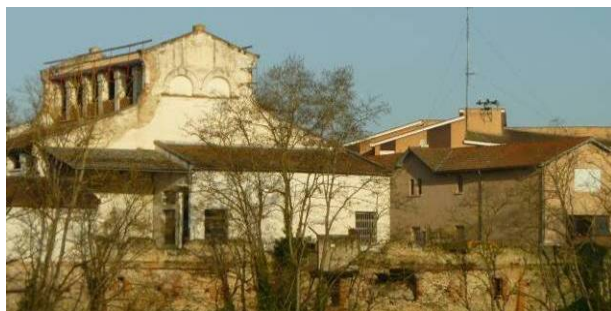
Vue générale depuis l'est avant réhabilitation (2011).
