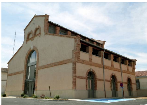
Le bâtiment central réhabilité, vu depuis le nord-est.
