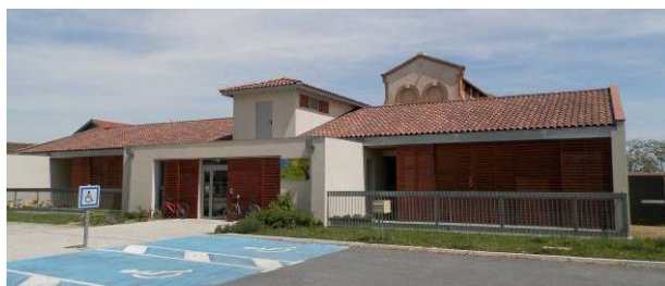
Bâtiment reconstruit à l'ouest en 2010 (Espace petite enfance intercommunal).
