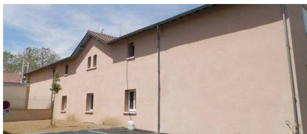
Bâtiments annexes au nord (casernes des sapeurs-pompiers).
