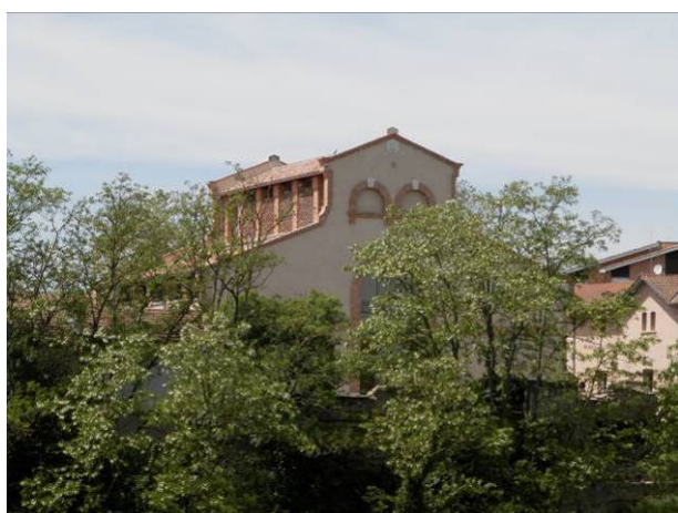
L'édifice restauré dans son site, au bord de l'Agout, vu depuis le pont Saint-Roch.
