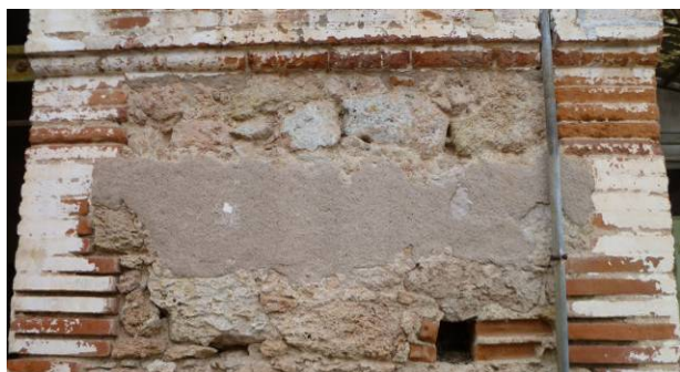
Détail de la maçonnerie mixte destinée à être enduite, et des encadrements en brique apparente.
